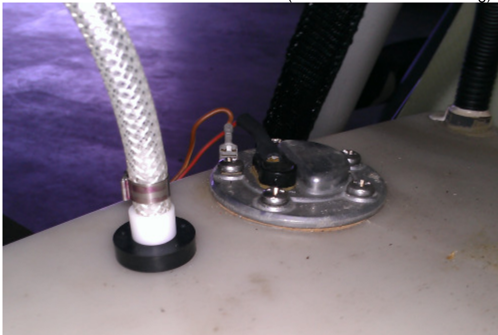
Bild 8 Rücklaufstutzen mit Gummimuffe (für Tank ohne Vorbereitung)
