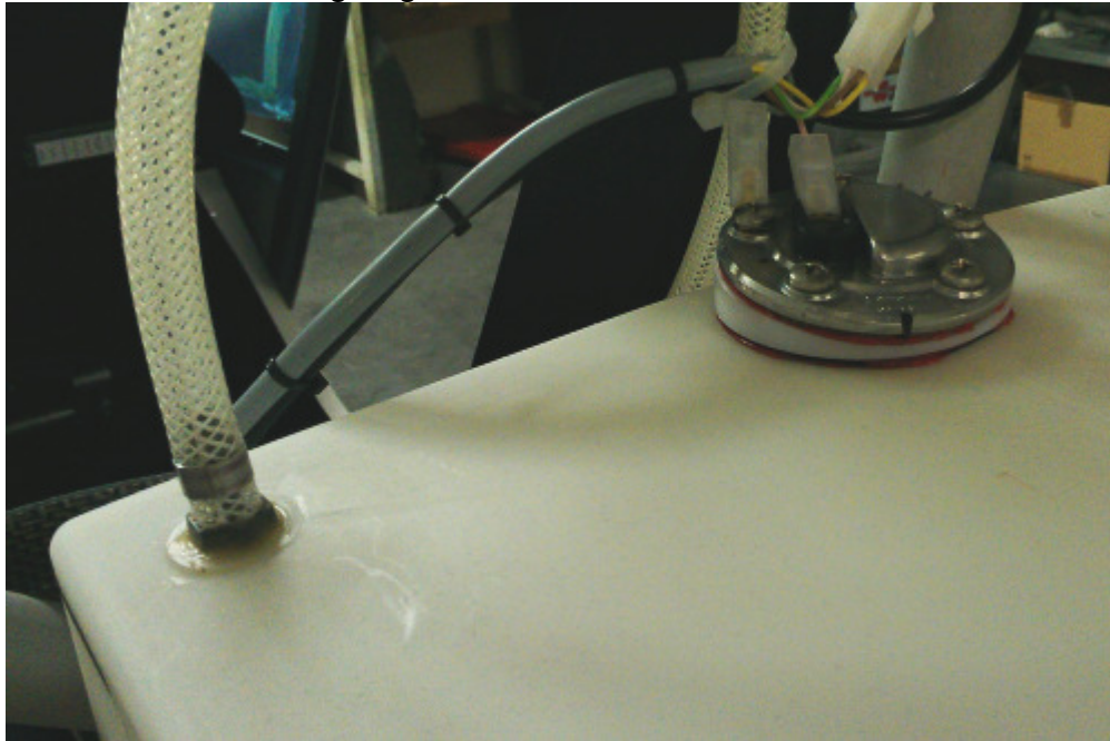
Bild 7 Rücklaufleitung angeschlossen
