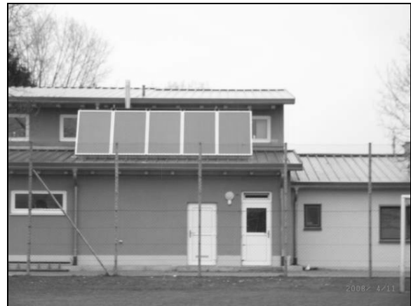
Abb. 2: Solaranlage SV 67 Weinberg
