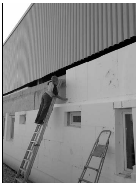
Abb. 1: Außenwanddämmung einer Flugzeughalle
